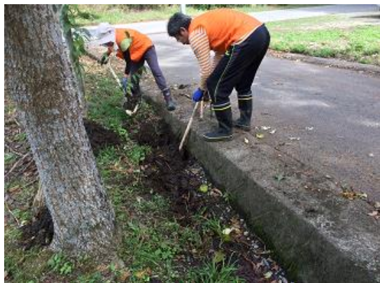
側溝の泥出し
